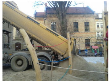
Einer von mehreren LKW der Firma Papenburg, die insgesamt 90 Tonnen Sand für den neuen Spielplatz spendete.
